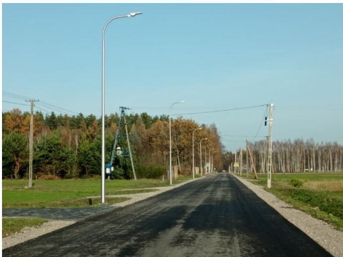
Budowa drogi w miejscowości Kierz
