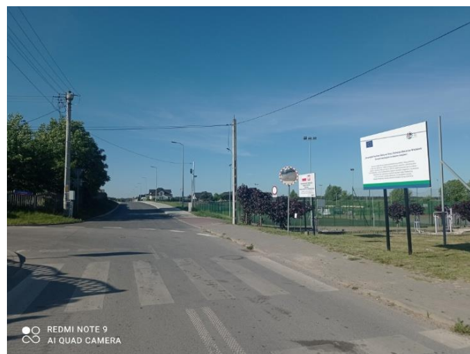
Rozbudowa ul. Sportowej i Leśnej
