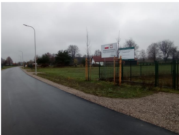
Budowa drogi w miejscowości Kierz
