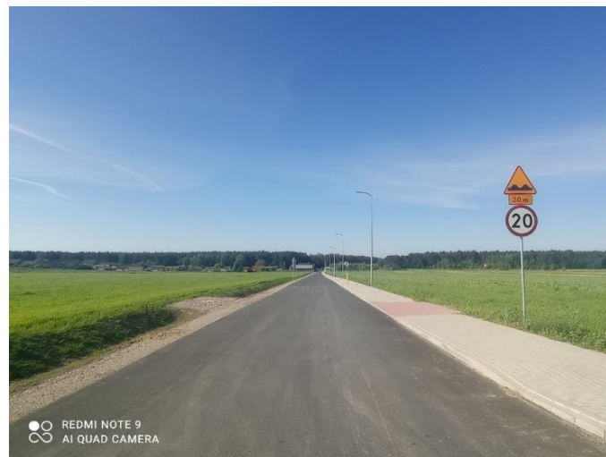
Rozbudowa ul. Sportowej i Leśnej
