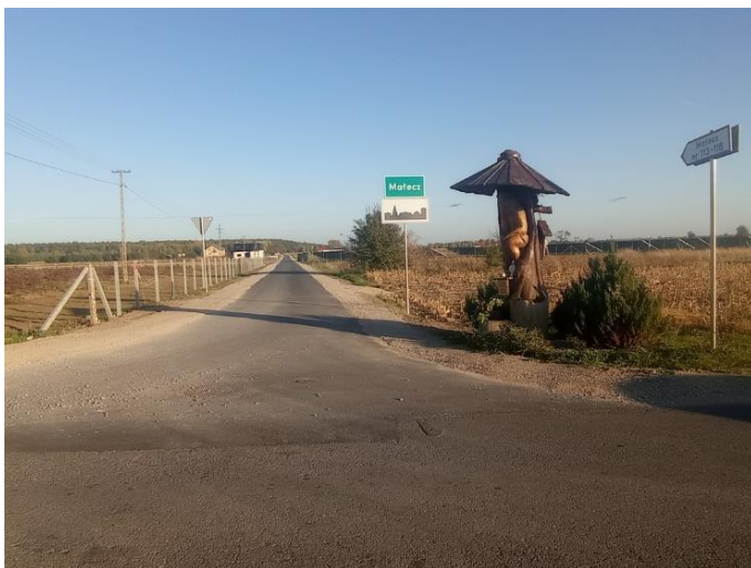
Modernizacja drogi gminnej we wsi Małecz
