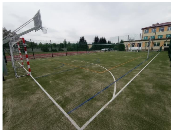
Przebudowa boiska sportowego wraz z bieżnią i skocznia w dal
